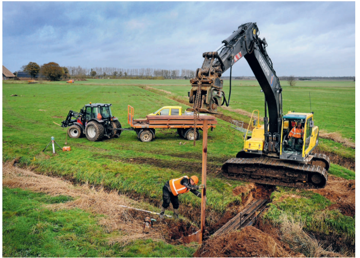
Grondwerk in de Polder Waard Nieuwland voor een eerdere kavelruil vanwege het Wieringerrandmeer. Foto: John Oud
